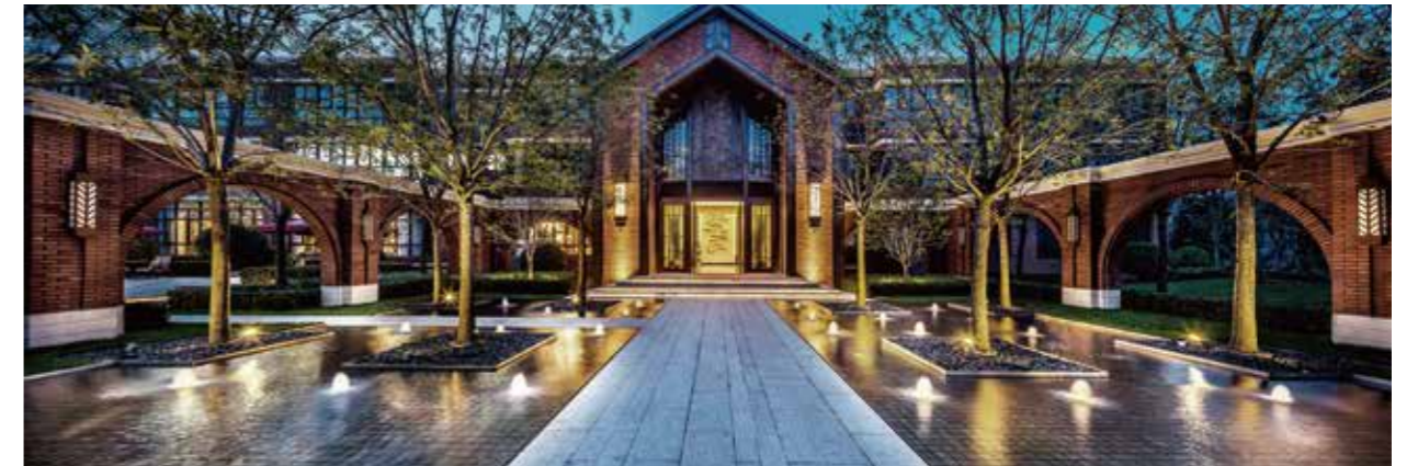
北京首开华润城项目
