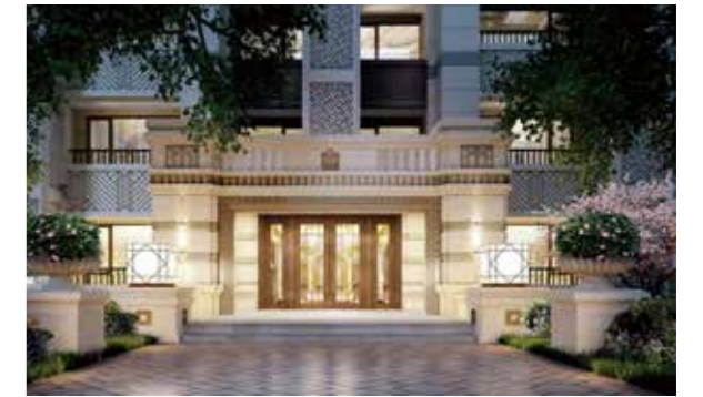
北京首开华润城项目
