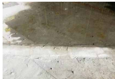
静力切割区域围堰
