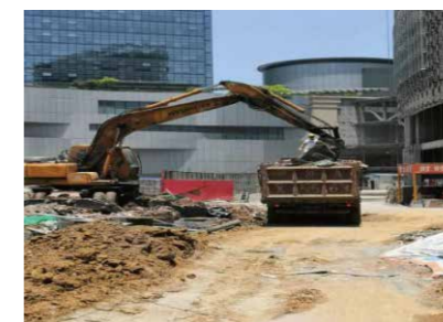
建筑渣土外运
