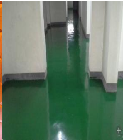
老项目地下车库地面升级改造
