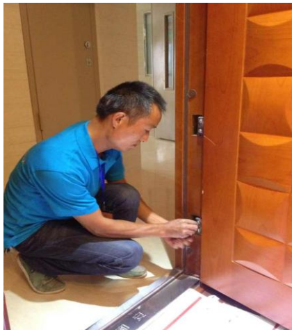
房屋维修保养
