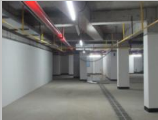
地下车库安装保洁取水点
