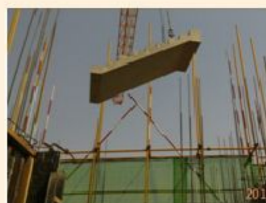
3 吊装至作业面
