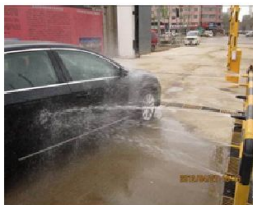
项目现场洗车设施效
