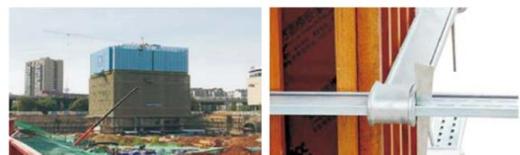
成都万象城二期项目采用爬架、方圆扣、铝膜、钢木方等新型材料工艺，改善施工现场作业环境。
