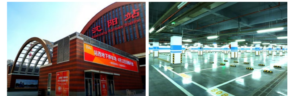
沈阳站西广场地下停车场
