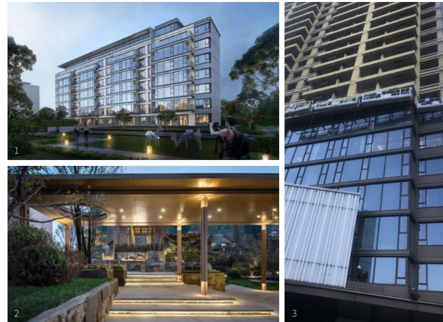
1. 沈阳昭华里外立面效果图、2. 长春公元九里示范区实景图、3. 沈阳瑞府外立面设计实景图
